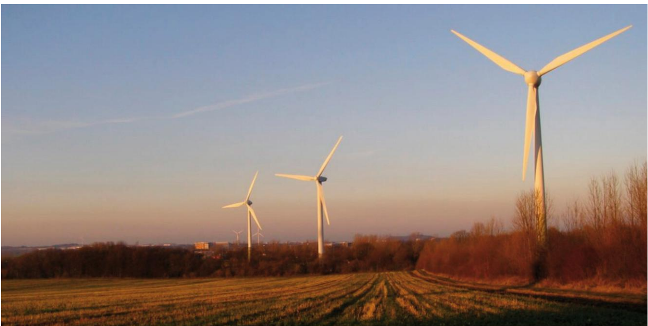
bestehende Turbinenstellungen in der Nähe von Königsbosch, Lanakerveld und in der Nähe von Avantis/Trilandis
