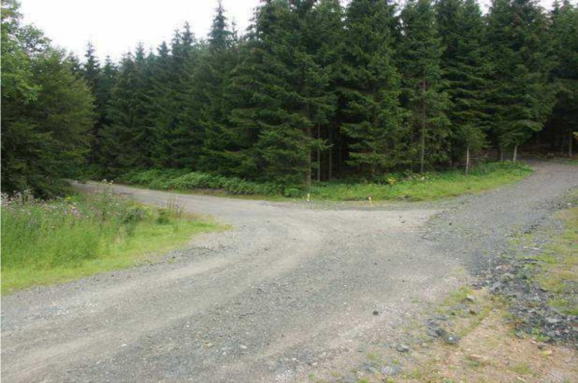
Abbildung 6: Kurvenradius einer Zuwegung zu Windenergiestandorten im Gelände
